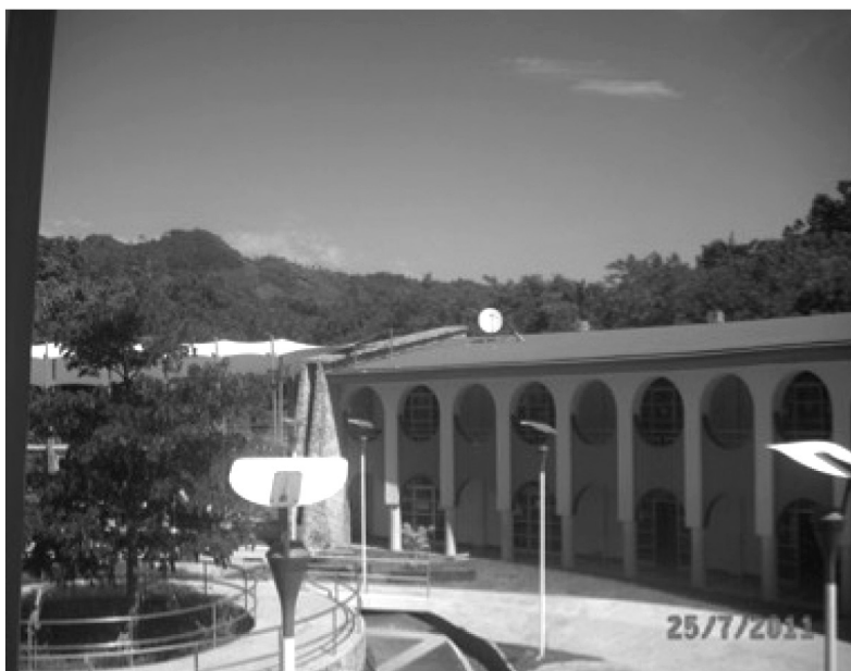
Foto 3. Instalaciones de la UIET en Oxolotán Tabasco
