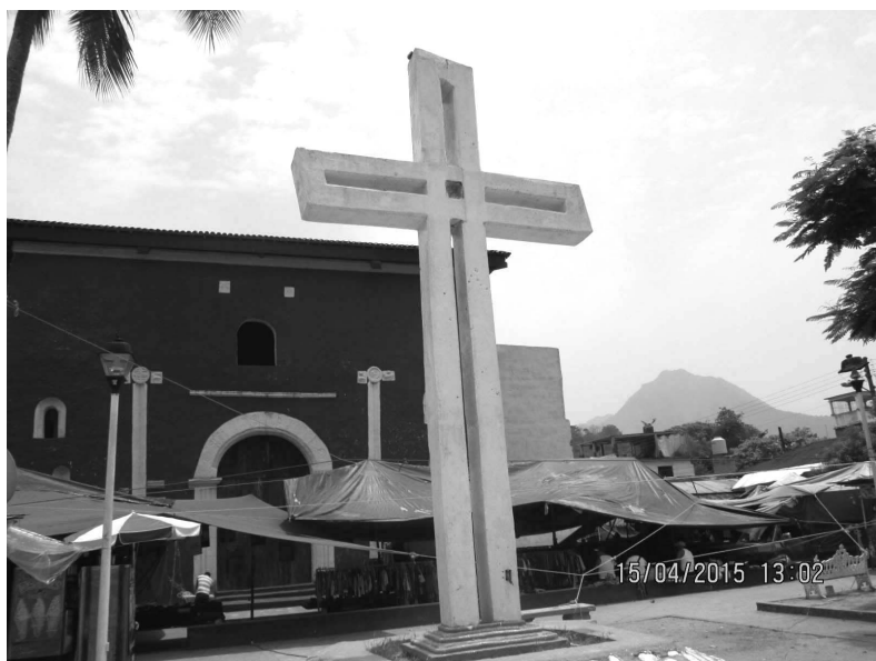
Foto 2. Fachada principal del ex Convento Dominico en Oxolotán.
